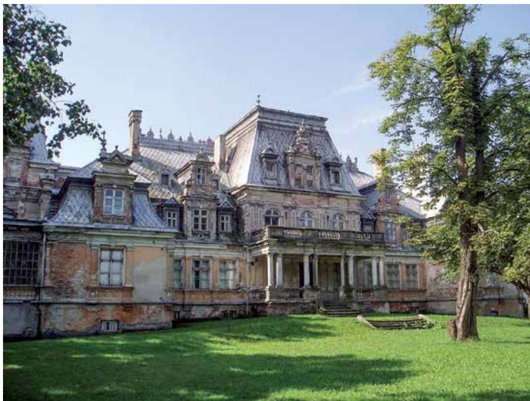
7 | Pałac od strony podjazdu, stan w 2007 r.
