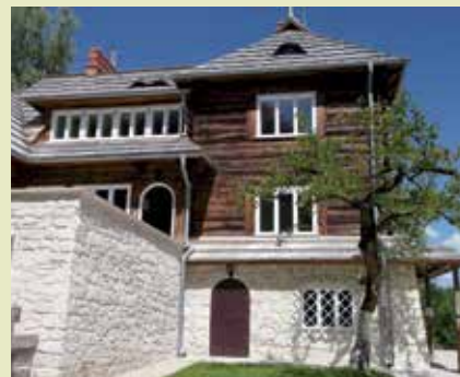
Dom Kuncewiczów w Kazimierzu Dolnym po remoncie
