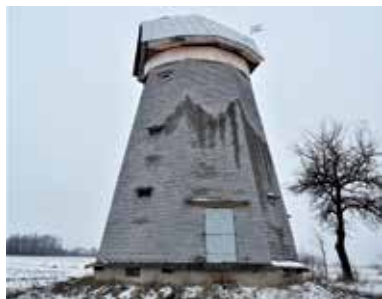
Odremontowany wiatrak z Szaciłówki
